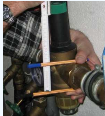
Abb. 5: Abstand der Stifte mit Meterstab ausmessen
