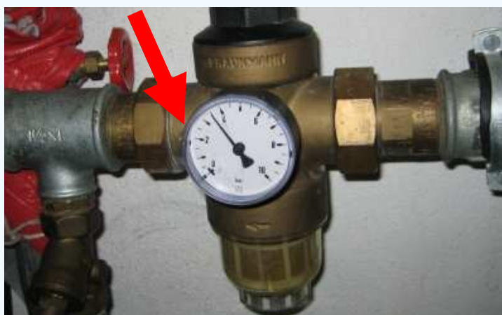
Abb. 3: Anschlussgröße eingekerbt am D06F (roter Pfeil, hier: hinter dem Manometer)
