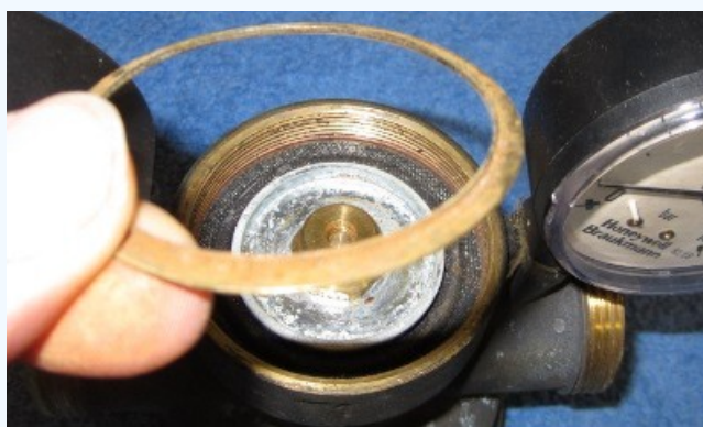
Abb. 2: Herausnehmen des Gleitrings
