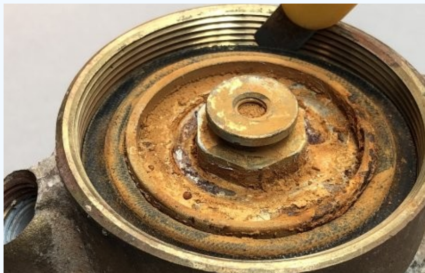
Abb. 3: Herausnehmen der Membran (Augen- und Handschutz tragen!!)
