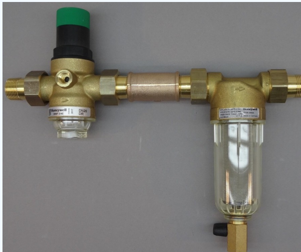
Abb. 2: Klassische Lösung mit Rohrstück zwischen den Verschraubungen
